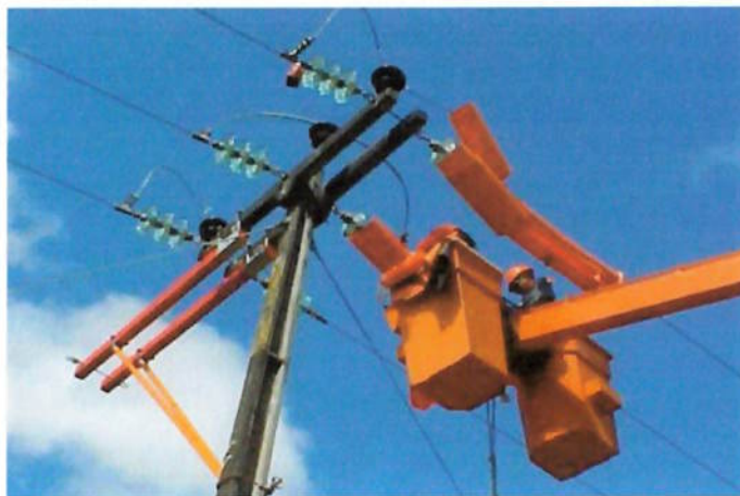
Figura 4-4: Linha Viva com método ao contato Fonte: (Acervo pessoal)
